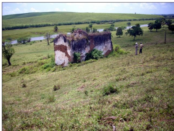
Figura 27 - Igreja em Ruínas do Engenho São João. Fonte: Acervo LA/UFPE.
