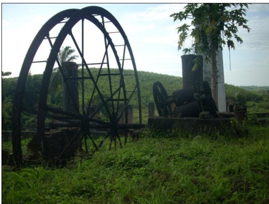
Figura 23 - Ruínas da Fábrica do Engenho Tapacurá. Fonte: Acervo LA/UFPE.
